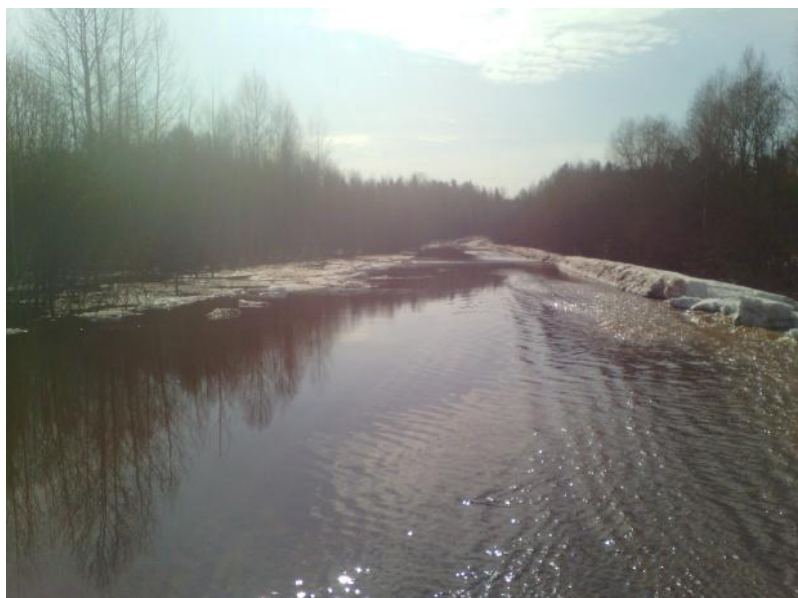
Рис. 9. Затопление автодороги в Нагорском районе
