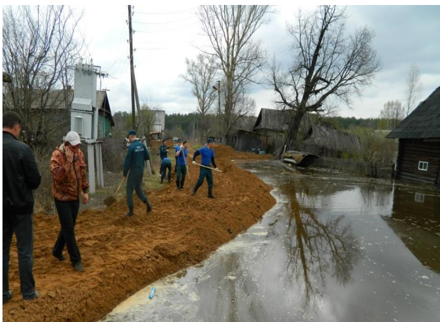
Рис. 3. Проведение работ по укреплению дамбы в пгт Аркуль Нолинского района
